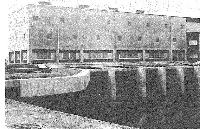
▲堀川排水機場が完成
